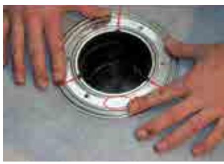
4. Appoggiare la guaina di impermeabilizzazione sopra la flangia di impermeabilizzazione e far combaciare l'anello inox, fare attenzione alla parte superiore dell'anello!
