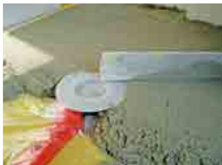
1. Riempire con il massetto e, partendo dalla protezione per il cantiere dello scarico, lasciare in pendenza
