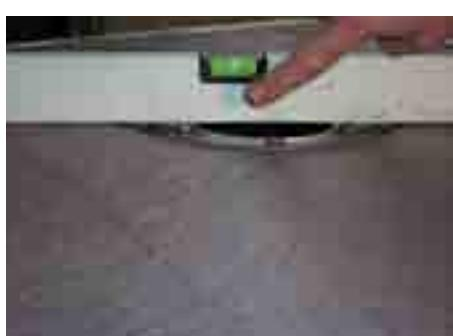
10. Piastrellatura senza problemi: il kit di impermeabilizzazione si trova sotto il livello superiore del massetto
