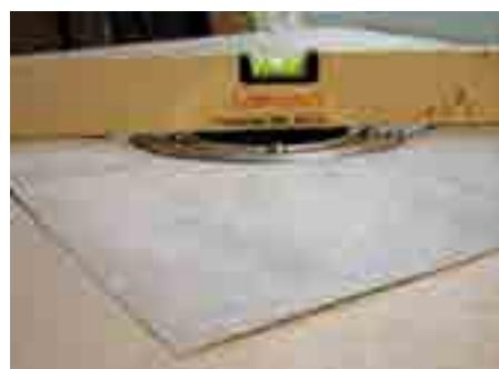
6. Il kit di impermeabilizzazione si trova sotto il bordo superiore del massetto
