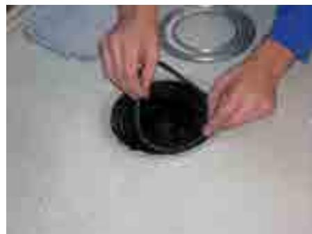
3. Levare la protezione per il cantiere e pulire la flangia di impermeabilizzazione, alloggiare la guarnizione nella fessura della flangia di impermeabilizzazione
